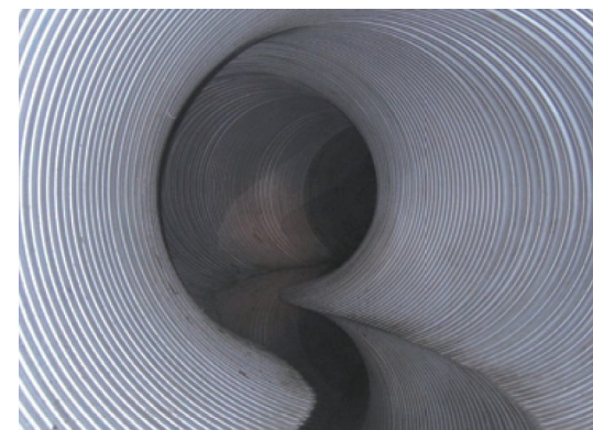
Sanierung von Bögen
